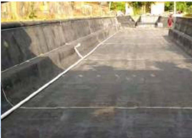
Kolam Landscape Kantor Kab. Badung - Bali
