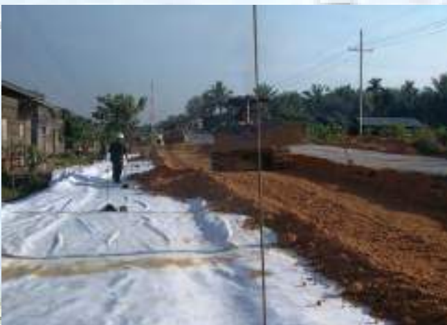
Separasi Timbunan, Jalan Lintas Propinsi - Riau
